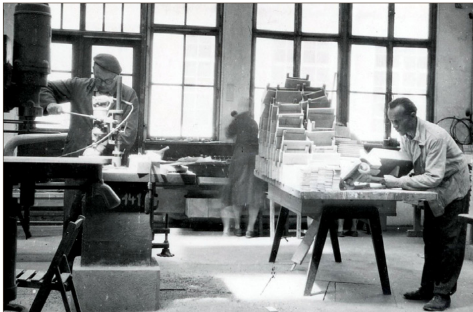
Obrázek 5: Pohled do interiéru vzorkové dílny v Praze-Líbni, která byla vybudována pro zpracování dřeva /květen 1951/ (ANM, f. ÚLUV, K_3349).
