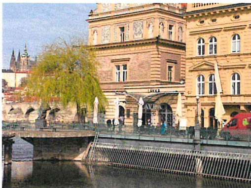
Pohled na budovu č.p. 201/1 z ul. Smetanovo nábřeží
