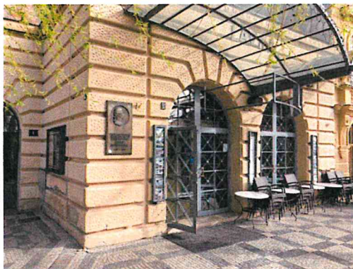
Vstup do prostoru restaurace Klub Lávka z ul. Novotného lávka
